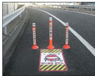
IC 入口部の路肩に設置した進入禁止ポール、進入禁止看板、通行禁止路面標示
