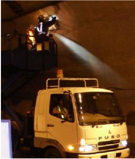
トンネル照明灯具 緊急点検状況
