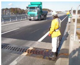
(土木)日常点検
