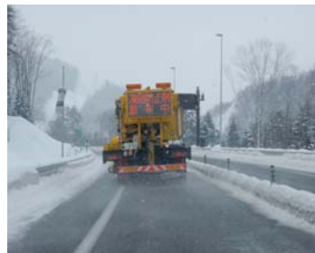
雪氷対策作業状況 (凍結防止剤散布)
