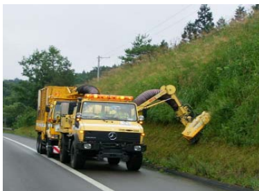
植栽作業状況
