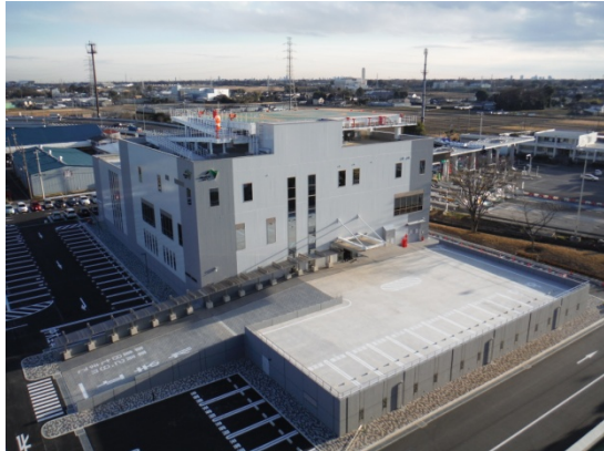
道路管制センター
