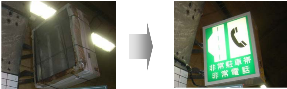
(施設)緊急対応が必要な損傷の補修状況
