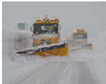
雪氷対策作業状況(除雪)
