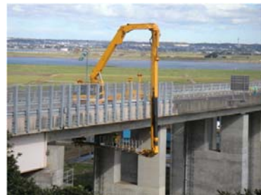
(土木)詳細点検
