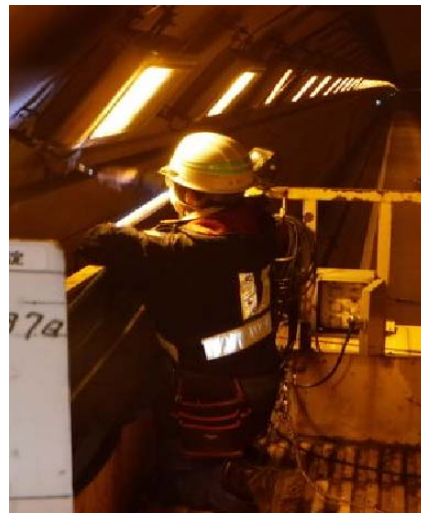
トンネル照明灯具 緊急点検状況
