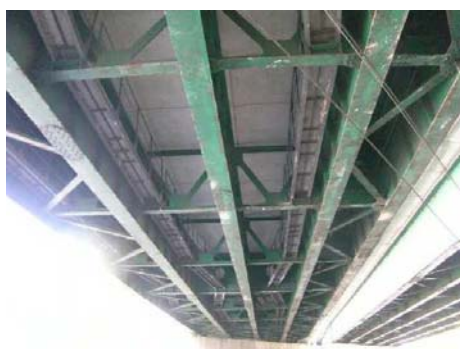
塗装劣化部の塗替塗装 東北道 仙台宮城IC～泉IC
