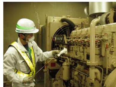
(施設)自家発電設備の点検
