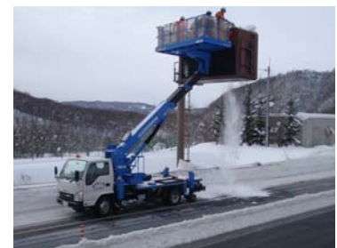
雪氷対策作業状況 (情報板雪落とし)
