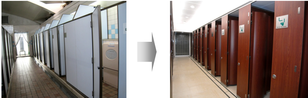
《トイレリフレッシュ》 トイレ床の段差解消、内装改修
